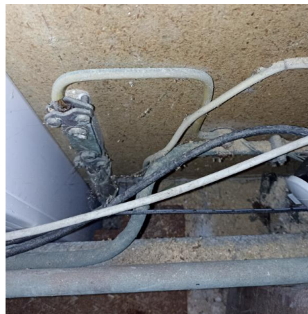
Figure 10 : Mise à la terre charpente bâtiment 2 et Barette de terre Local Téléphonique bâtiment 1.
