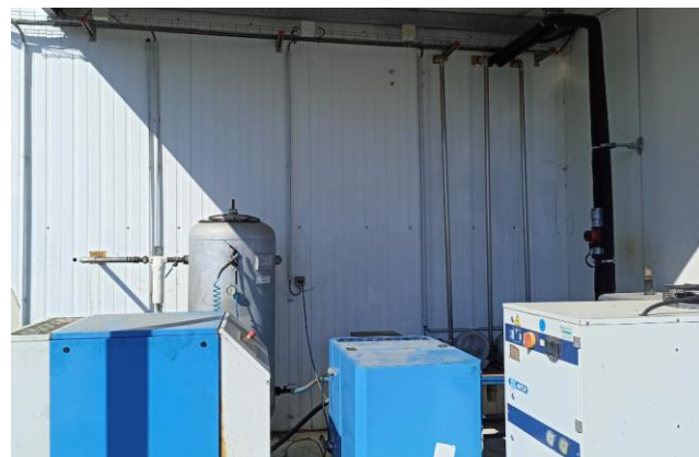
Figure 12 : Mise à la terre canalisation cuivre eau froide + Compresseur et canalisation air comprimé
