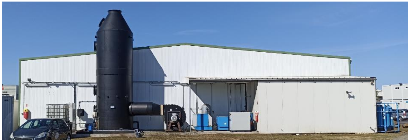
Figure 5 : Façade Est - Bâtiment n° 2
