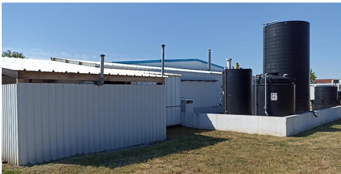
Figure 7 : Façade Nord - Bâtiment 1
