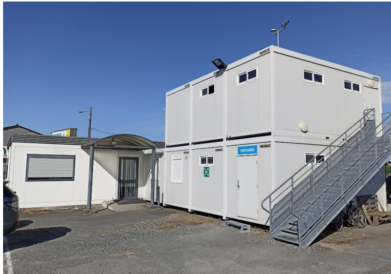
Figure 4 : Bâtiment accueil et Vestiaires
